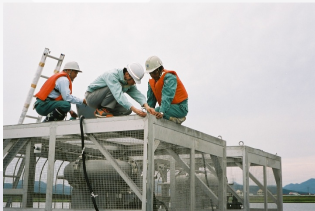
遠賀川河口堰
